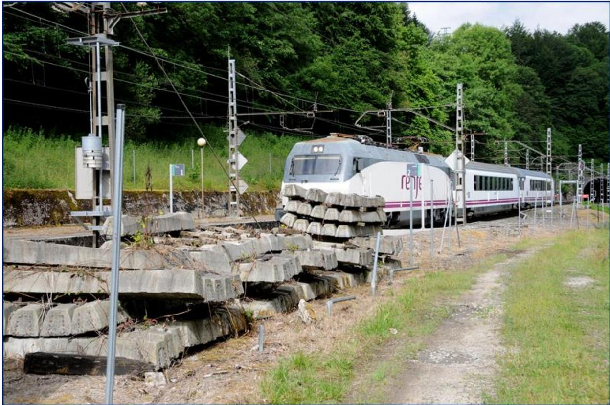
Figura 56. Estado del actual apeadero de Otzaurre, antigua estación. La presencia de elementos abandonados e incluso la ausencia del vallado de la vía configuran alguno de los impactos presentes y amenazan la seguridad.
